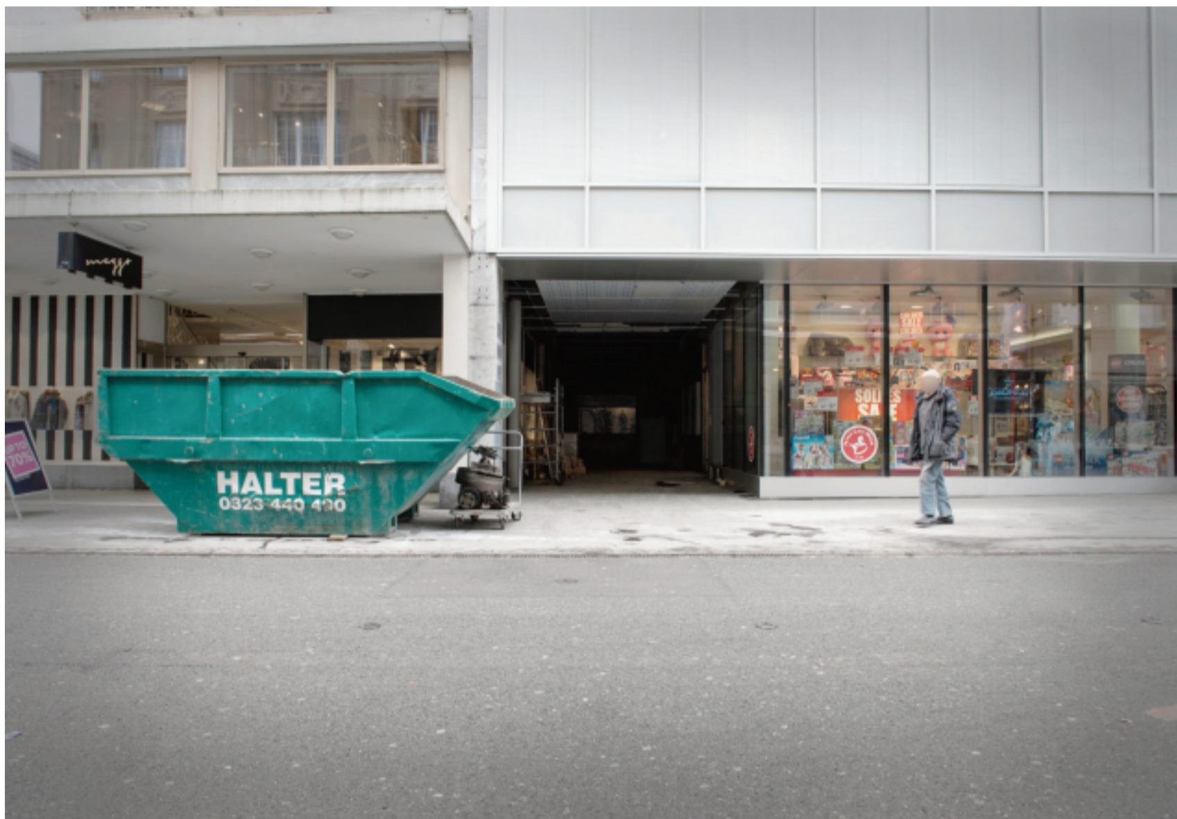
An der Nidaugasse 8 fand gestern Morgen eine grosse Baustellenkontrolle statt. Rund sechs bis acht Beamte sowie zwei Arbeitsmarktinspektoren waren dabei im Einsatz. Zwei Männer, die der Schwarzarbeit verdächtigt werden, wurden vorläufig festgenommen. Mindestens einer konnte fliehen.
